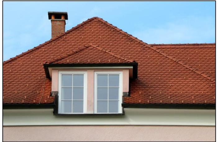
Der **Zwerchgiebel** unterscheidet sich von der Dachgaube dadurch, dass die Hauswand direkt in den Aufbau des Zwerchhauses übergeht. Zwerchhäuser/Zwerchgiebel werden ebenfalls hauptsächlich verwendet, um mehr Raum im Gebäude zu schaffen, das Tageslicht als Lichtquelle besser nutzen zu können oder auch zur besseren Belüftung.
