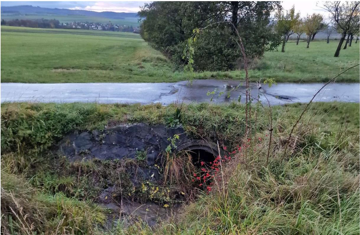
Abbildung 20: Verkrautete und sedimentierte Verrohrung.
